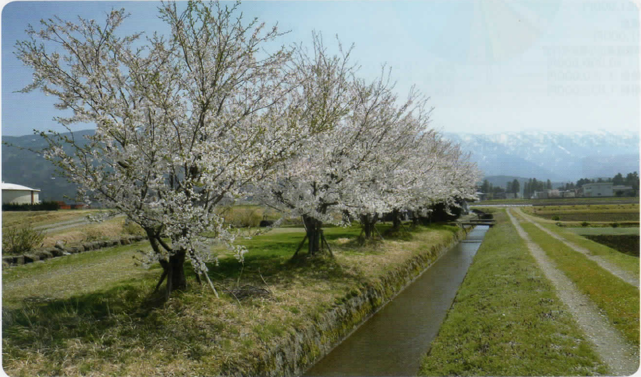
山見八ヶ用水路(南砺市森清、久保地内)
