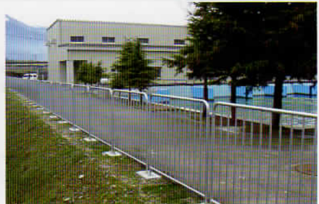
県営基幹水利施設ストックマネジメント事業「庄川地区」 共同場水機場 周辺工事【フェンス等修繕】(南砺市高瀬地区) 工事費 9,800,000円
