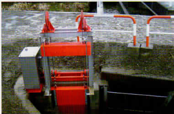
維持管理適正化事業 南砺用水路 利波川放水門改良工事 【洪水時、自動で放水門開放に改良】(南砺市細野地内) 工事費 3,200,000円
