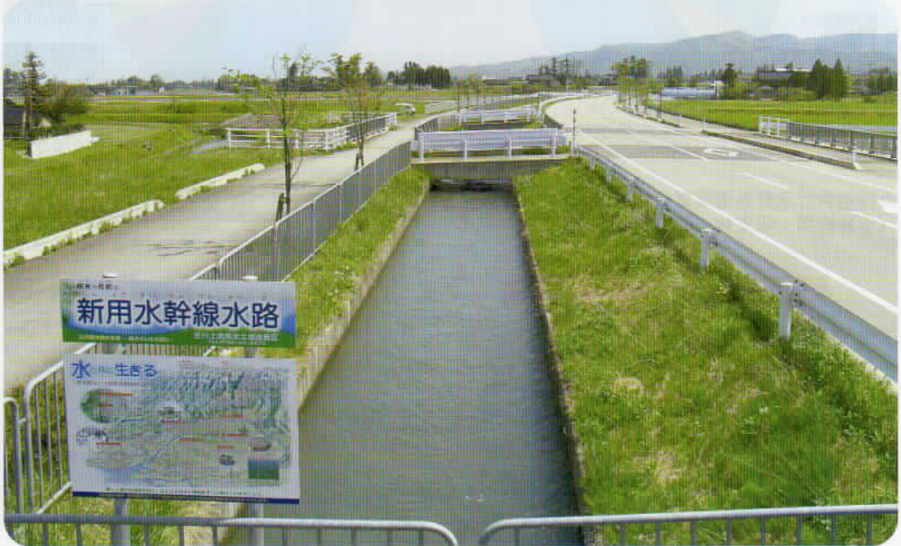
新用水幹線水路(南砺市沖地内)
