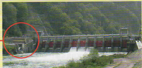
【庄川合口堰堤】
