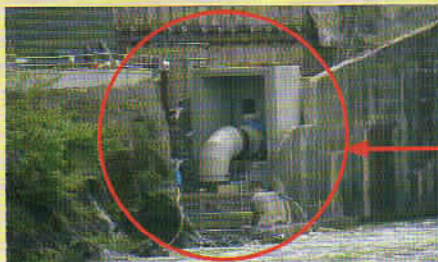
【建設中の庄川合口発電所】
