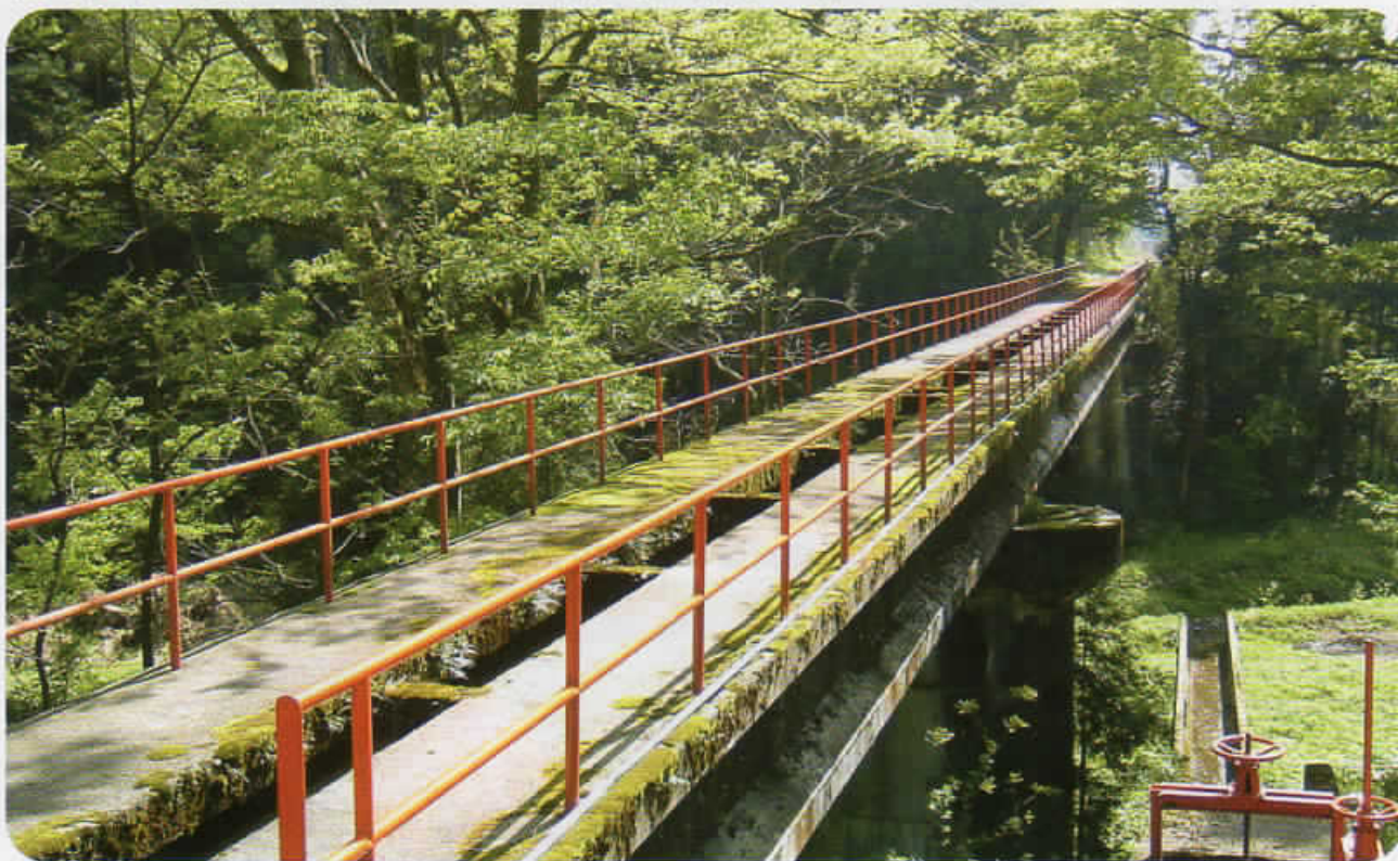
南砺用水路 東大谷水路橋 (南砺市井波地内)
