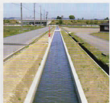
県営土地改良総合整備事業「福野北部地区」 清水清沢用水路（小矢部市清水地内他、 3工区 L=809m）
