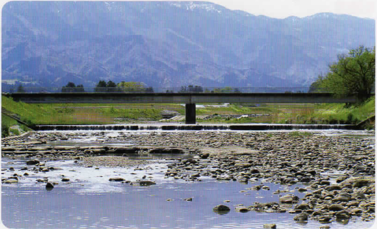
北山田用水 山田川水路橋（南砺市高島、上広安地内）
