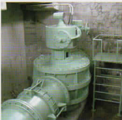
県営基幹水利施設補修事業「庄川地区」 ロータリ補修工事（南砺市高瀬地内：揚水機場）
