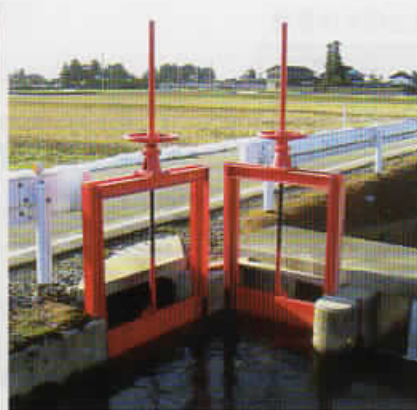
維持管理適正化事業「分水門点検整備」 （砺波市庄川青島地内他、水門等22門整備）
