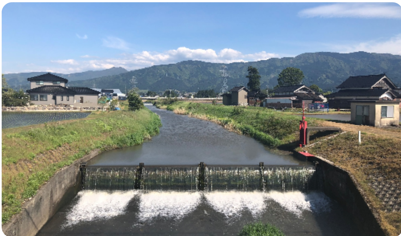
石田頭首工（南砺市江田地内）
