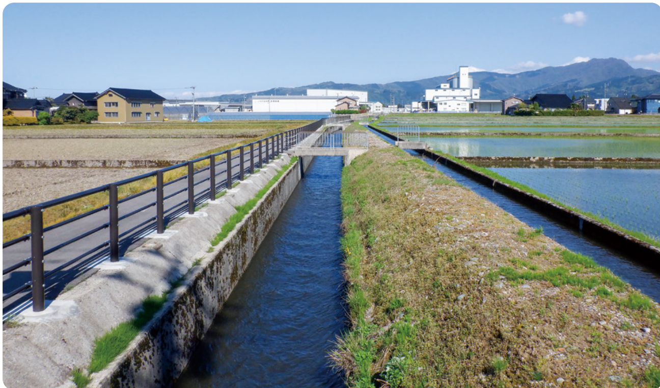
自転車道横を流れる苗島用排水路(南砺市苗島地内)
