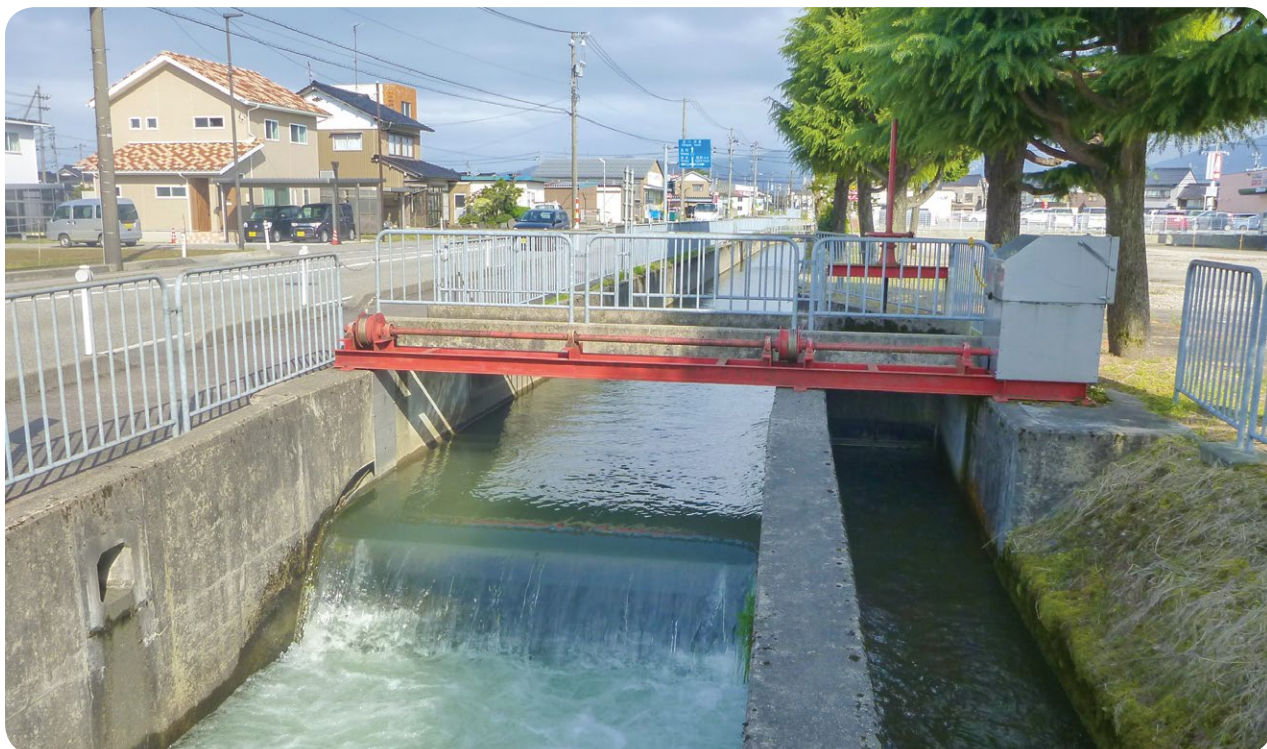
六ヶ用排水路(南砺市二日町地内)
