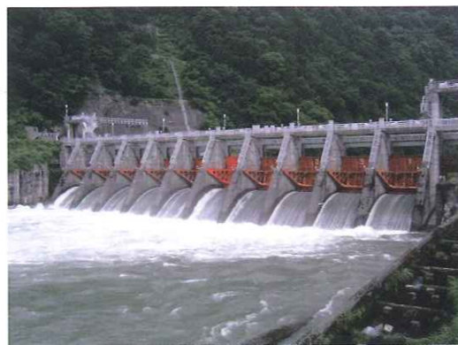
しょうがわごうくち 【庄川合口ダム】
